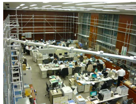
【修復工事中の営業場】
