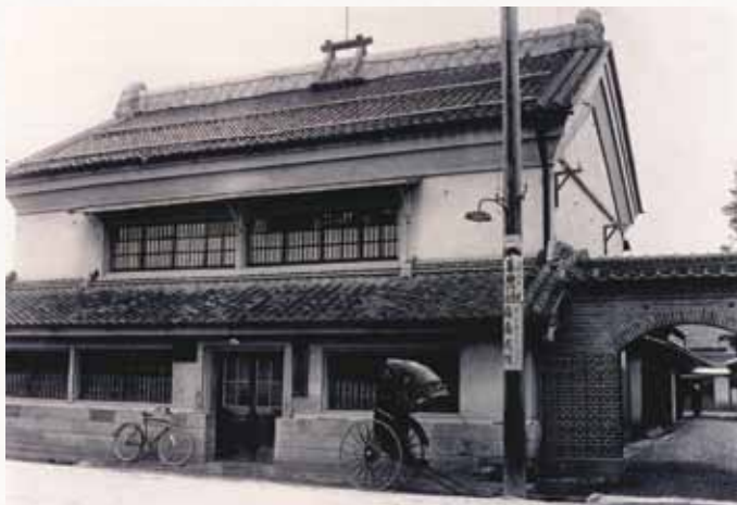
東北初の日銀店舗として開設された福島出張所。建物は生糸問屋「万国屋」から購入したもので、2階建て・土蔵造りであった
