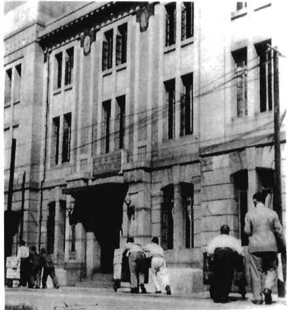
大分合同銀行門司支店内の仮店舗に現金を搬入する路上の日銀門司支店職員。
