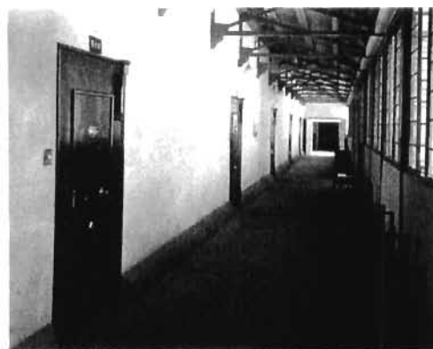
門司事務所営業所の金庫前廊下
