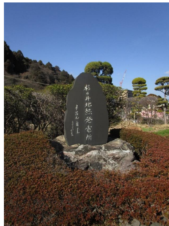
(図表5) 杉乃井地熱発電所
